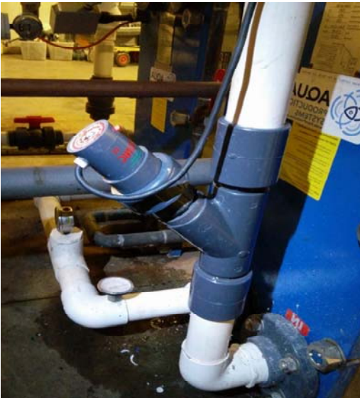
Пример: установка УЗО устройства на проточный теплообменник SONDEX
