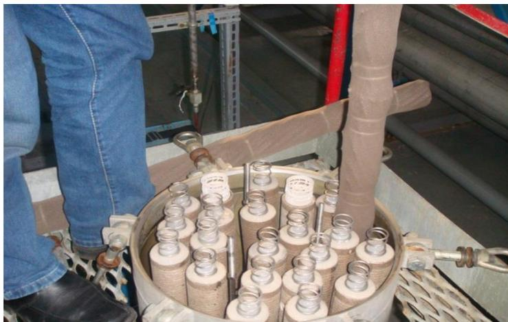
Abb. 15: Bestückung des Filtergehäuses mit Mineral-Metall-Drahtgestrick in Strumpfform
