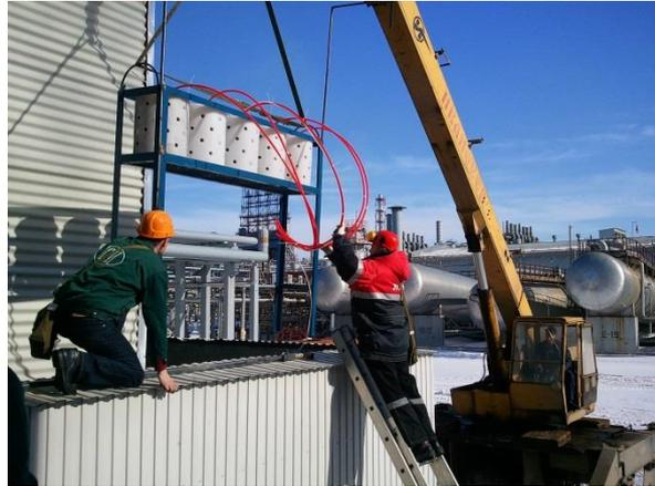
Abb. 5: Montage zylindrischer Katalysatorgehäuse
