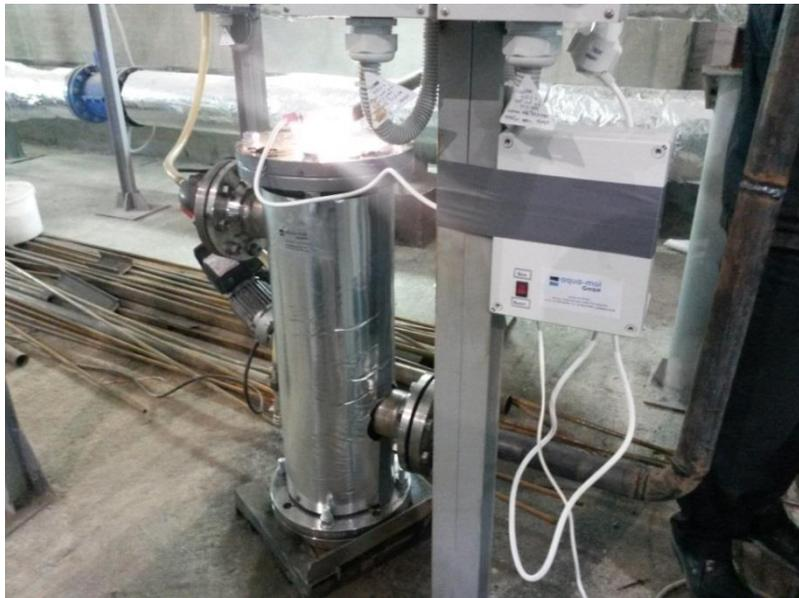
Abb. 17: Pilotanlage zur Eliminierung von sulfatreduzierenden Bakterien in Warmwasserversorgungssystemen
