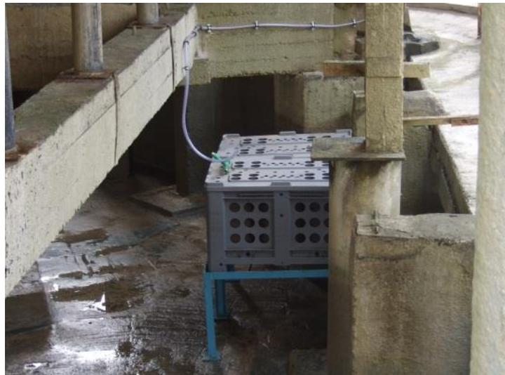
Abb. 3: Eingebaute Katalysatoren Typ MOL®GB 5000 in Kühlturmtasse
