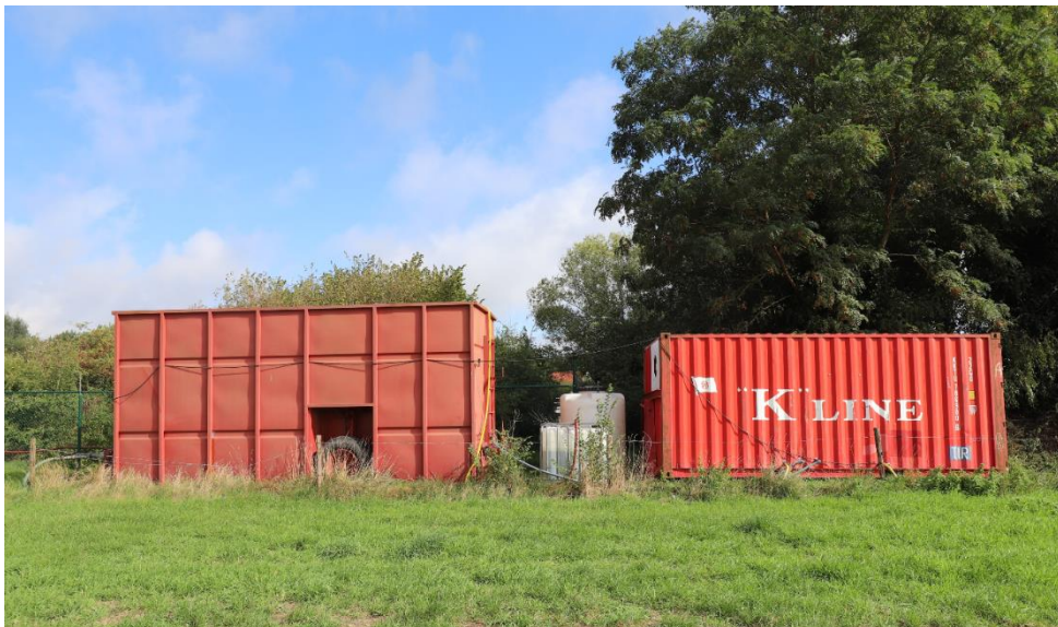
Figuur 18: overzicht van de zuiveringsunit met de rode container dat de zuiveringsinstallatie bevat (rechts), de tussenbuffer (centraal) en de buffertank (links) waar water wordt onttrokken voor irrigatie.
