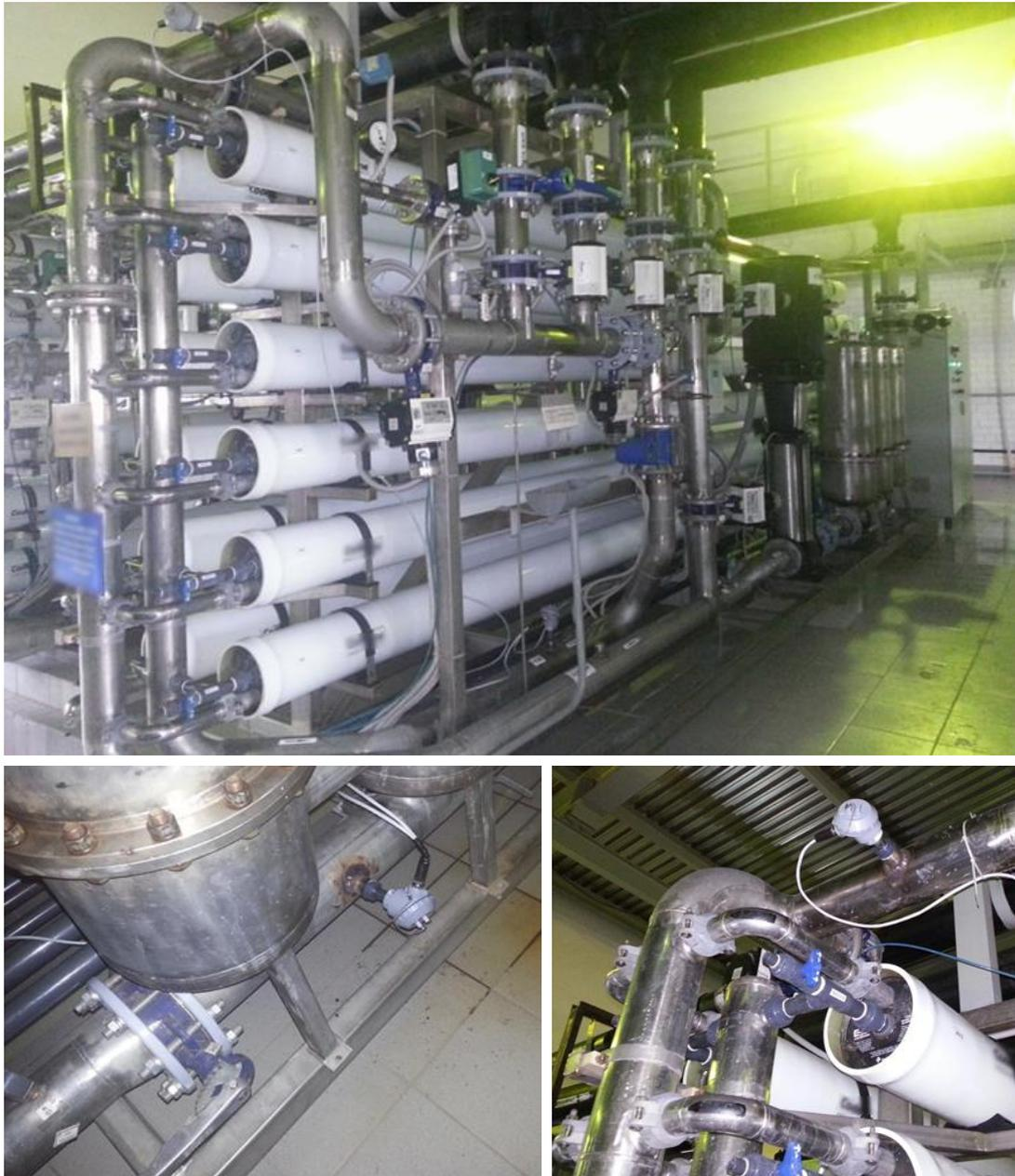
Figure 3: Vue d'ensemble du système OI (en haut), capteur ALVIM installé avant l'OI (en bas, à gauche), capteur ALVIM installé sur la ligne de concentrat (en bas, à droite)
