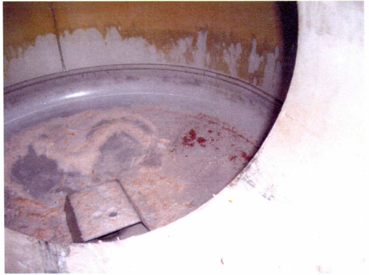
Foto 18: Auf dem Boden des Boilers hat sich eine Menge Kalk angesammelt
