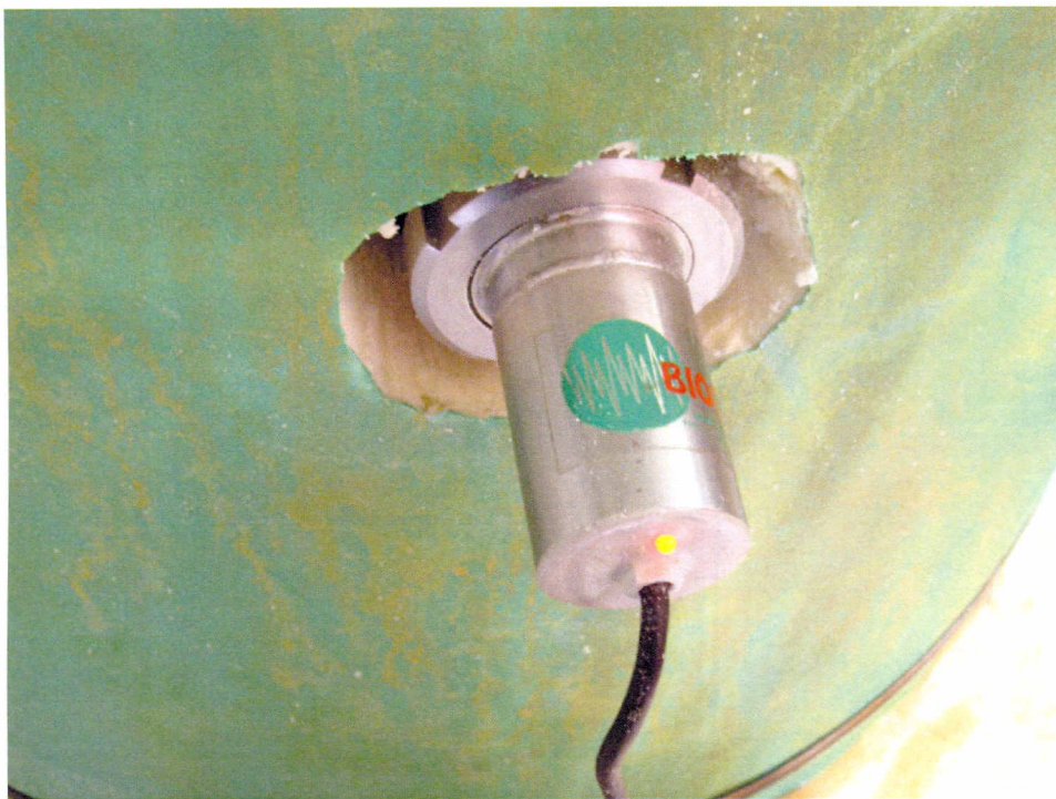
Foto 9: angeflanschter Powersonic. Boiler-Isolierung ausgeschnitten und wieder anmontiert, fertig.
