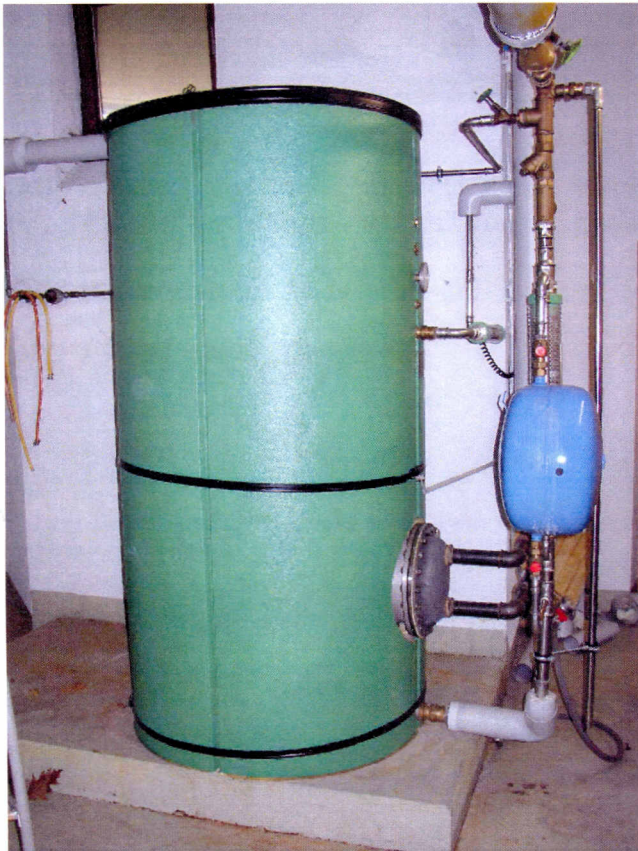
Foto 1) Warmwasser-Boiler
